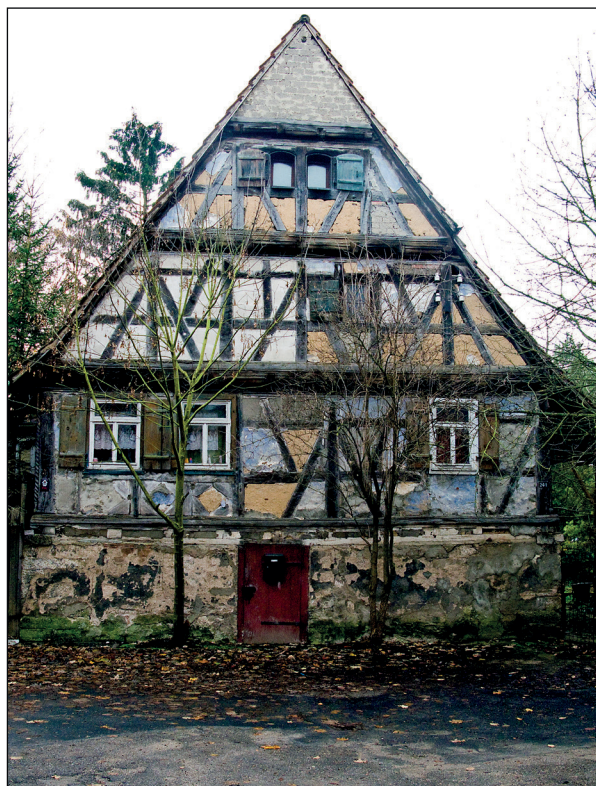
Blick auf die Nordgiebelseite im Altzustand.
