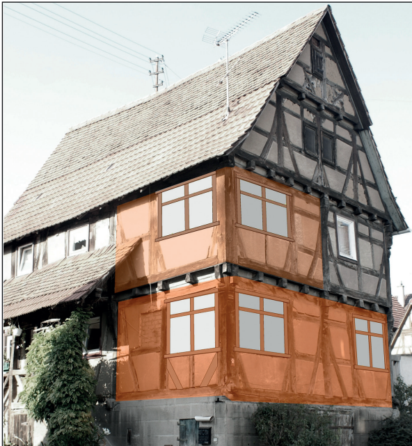
Farbig markiert: Lage der bauzeitlichen Stuben im Erd- und Obergeschoss mit Fenstererkern.
