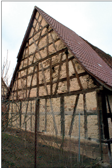
Südostansicht der Scheune vom Feuer-gässle aus
